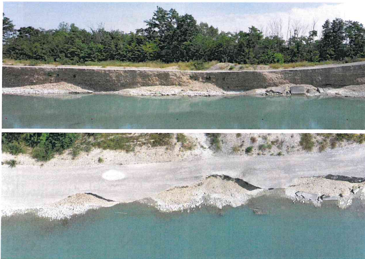
Figura 3 – Tratto in erosione appena più a valle della porzione di sponda oggetto dell'intervento. Si notano i detriti del crollo del muro di protezione della vecchia difesa.
